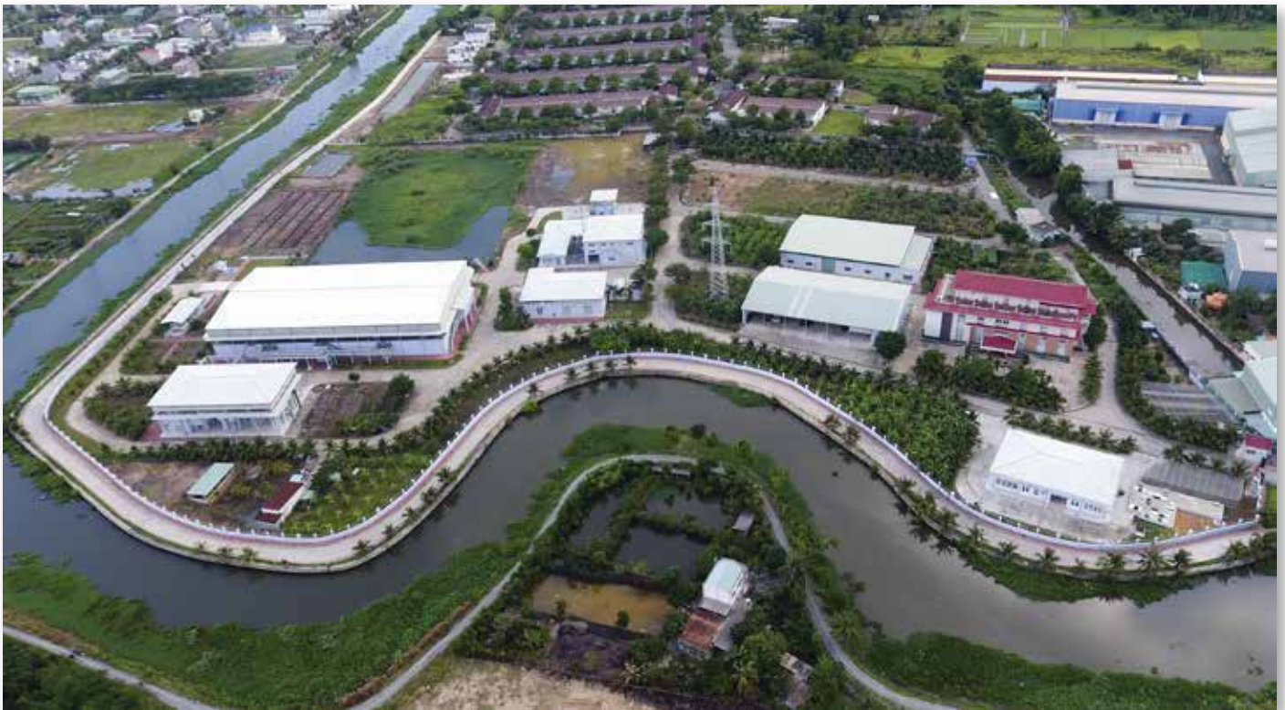
Nhà máy xử lý nước thải xanh, sạch.
