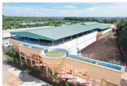
Khu xử lý Nhà máy nước Tân Hiệp
