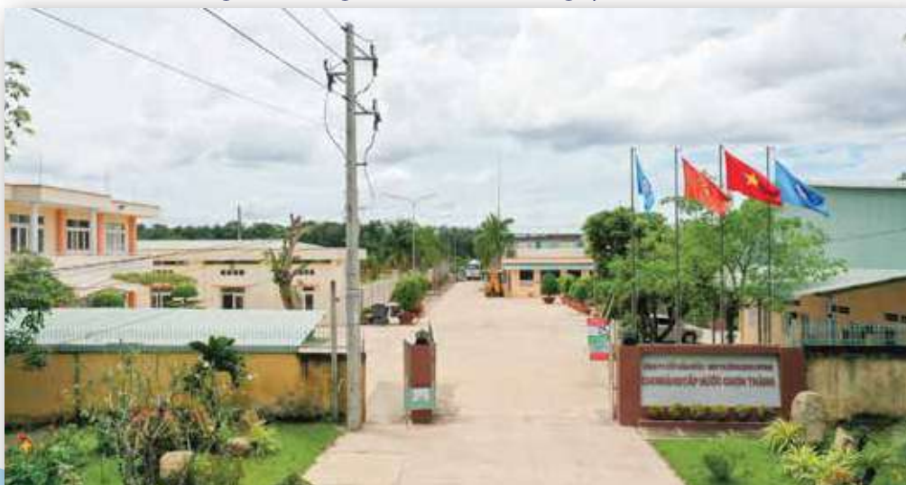
Chi nhánh Cấp nước Chơn Thành (Tỉnh Bình Phước)
