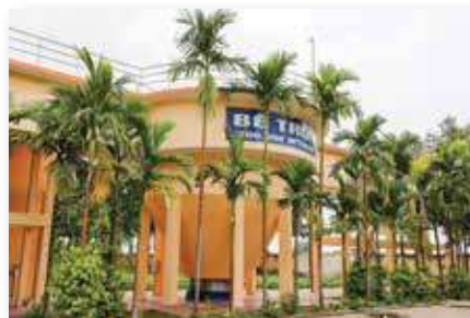
Bể trộn công suất 300.000m 3 /ngày
