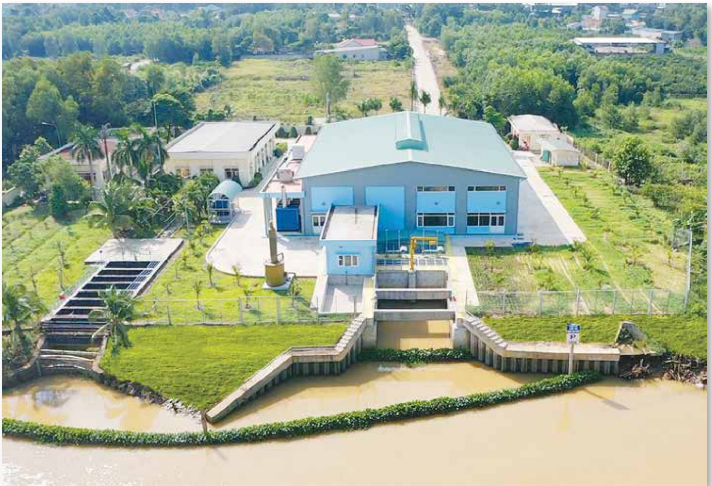
Trạm bơm nước thô Tân Hiệp – Công suất 600.000 m 3 /ngày đêm
