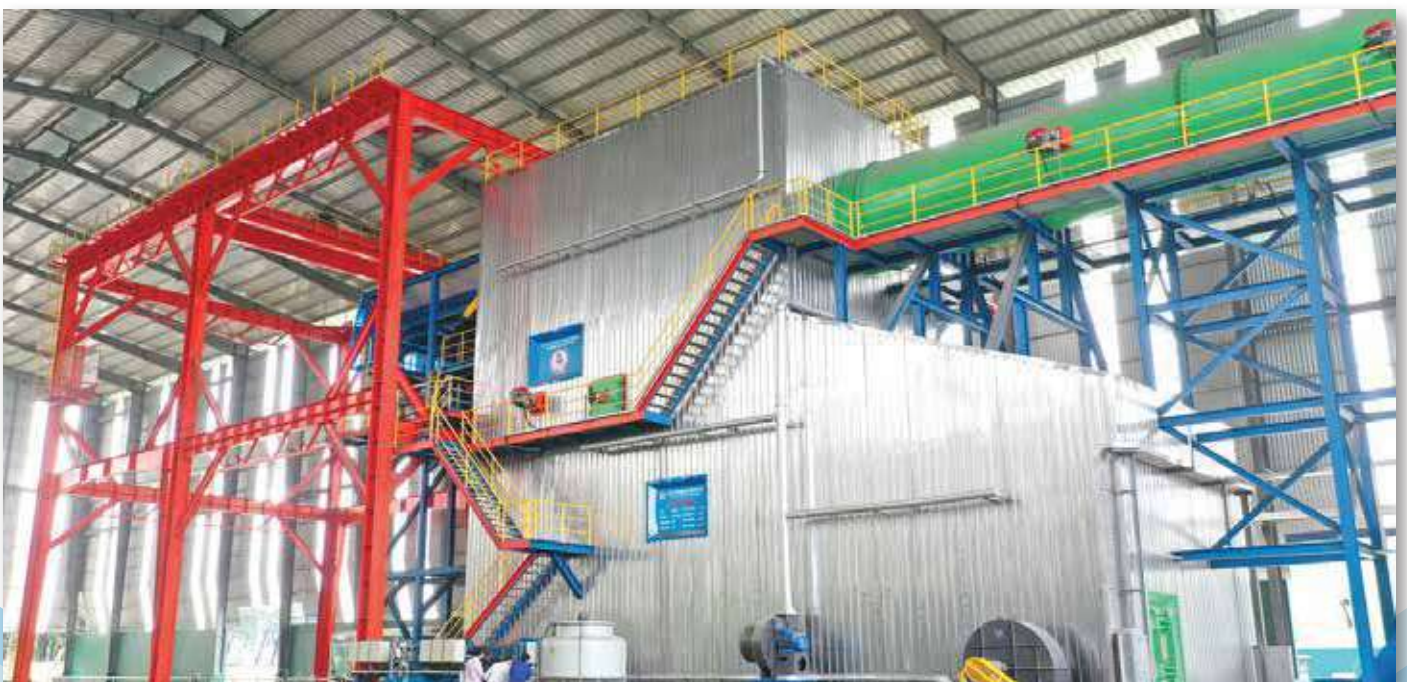
Lò đốt công suất 8.400kg/h
