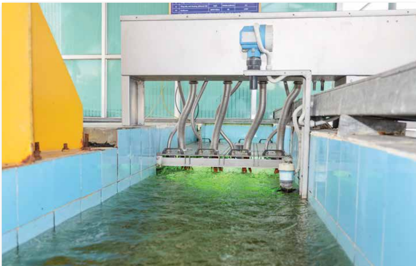
Hệ thống khử trùng bằng tia UV
