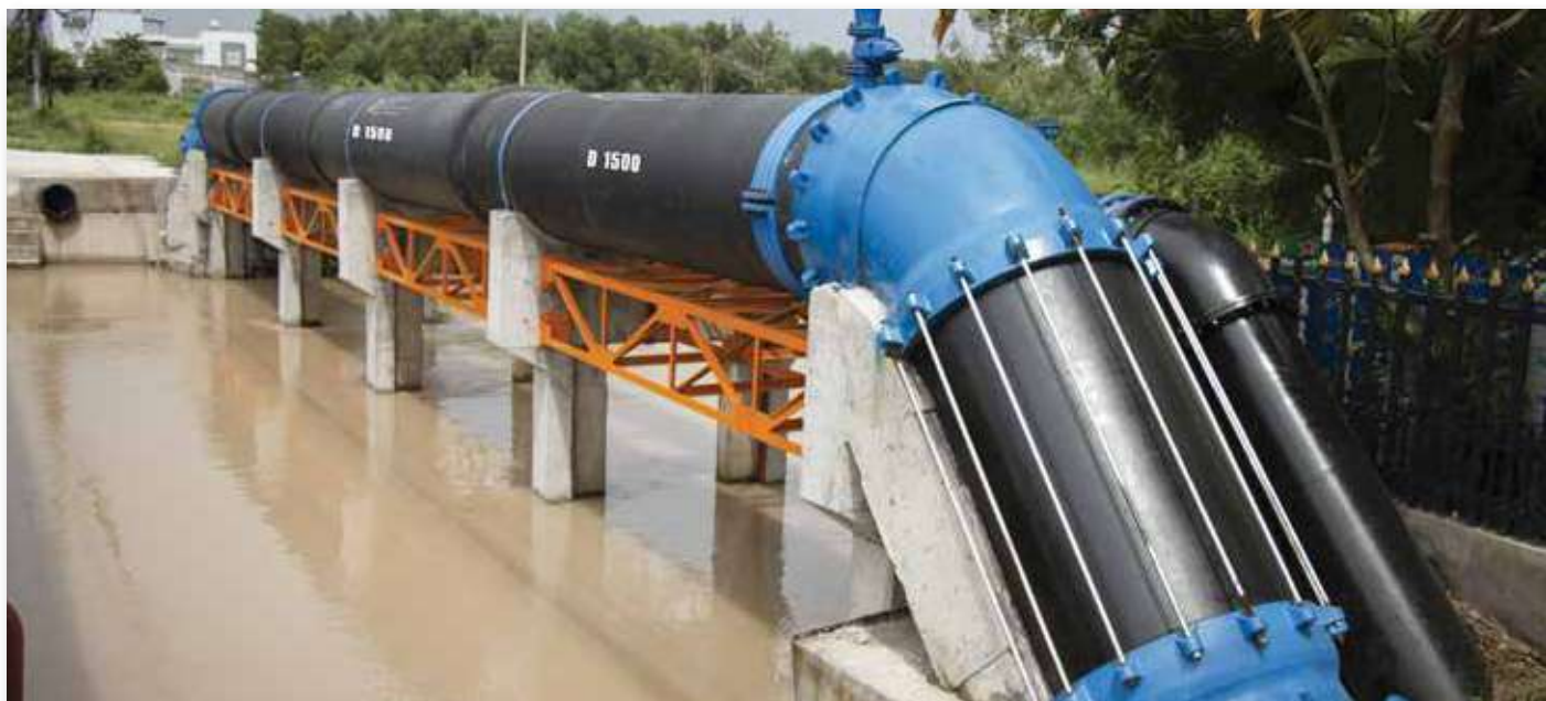
Tuyến ống nước thô Tân Hiệp D1500 mm
