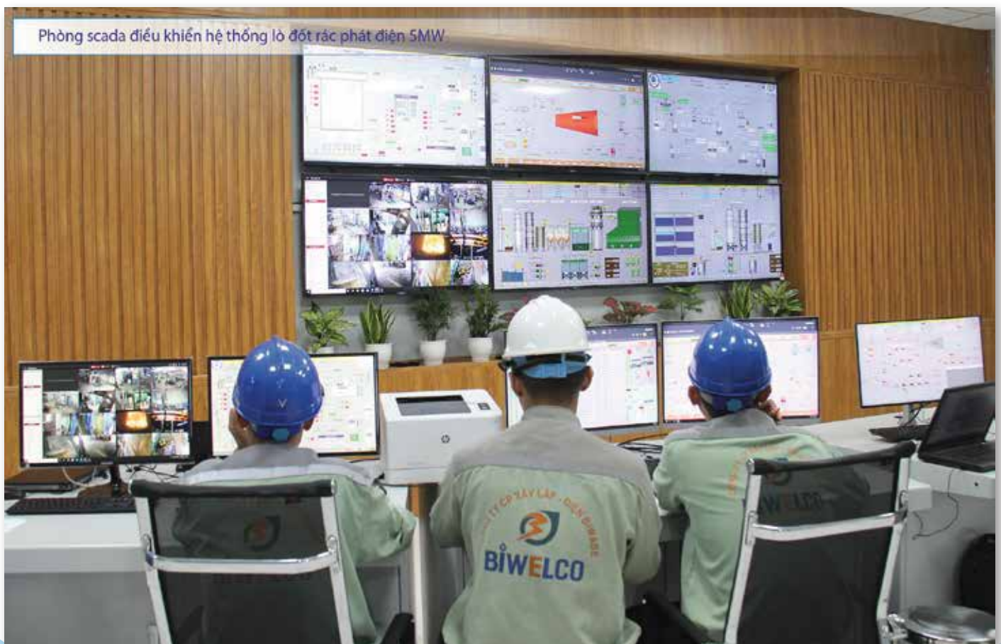
Phòng SCADA điều khiển hệ thống lò đốt rác phát điện 5MW
